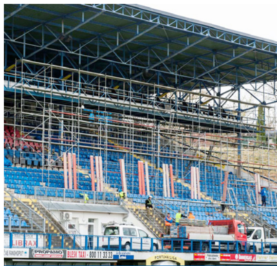
Oprava tribuny Stadionu U Nisy.
