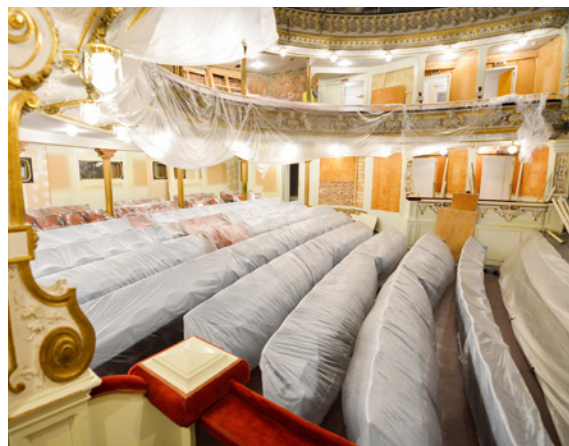
Obnova interiérů v Divadle F. X. Šaldy.
