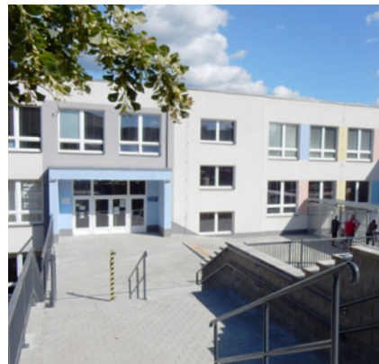
Stavební úpravy na Základní škole Aloisina Výšina.
